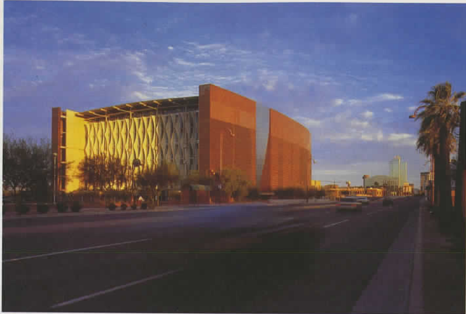
De noordgevel met 'shade sails'. The north wall with 'shade sails'.
