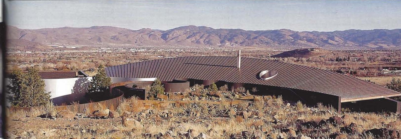
Das Haus folgt der Topographie und duckt sich an einen Abhang. Damit sucht es effektiven Schutz vor dem unaufhörlichen Wind.
